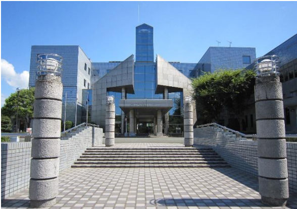
センター正面入口
